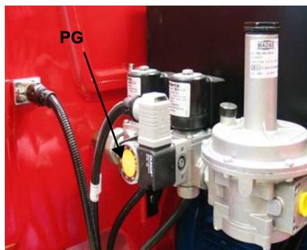
Fig. 27 - Pressostato gas
