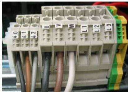
Рис. 24: Клеммник питания
