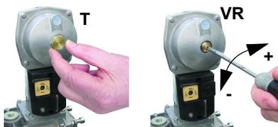
Pour augmenter ou diminuer la pression, et par conséquent le débit du gaz, agir avec un tournevis sur la vis de réglage VR après avoir retiré le bouchon T; visser pour augmenter le débit; dévisser pour le diminuer.
