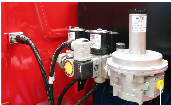
collegamento alla rete distribuzione del gas - 1/2"
