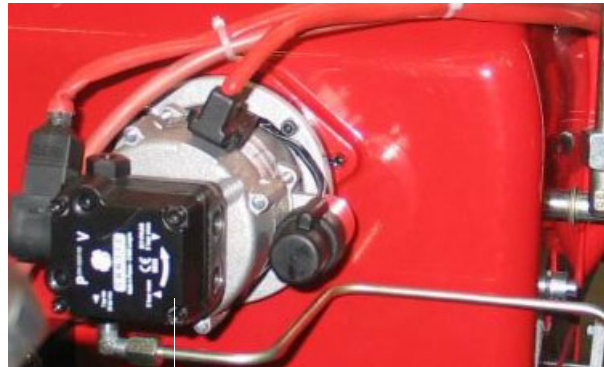
pompa pilota gasolio
