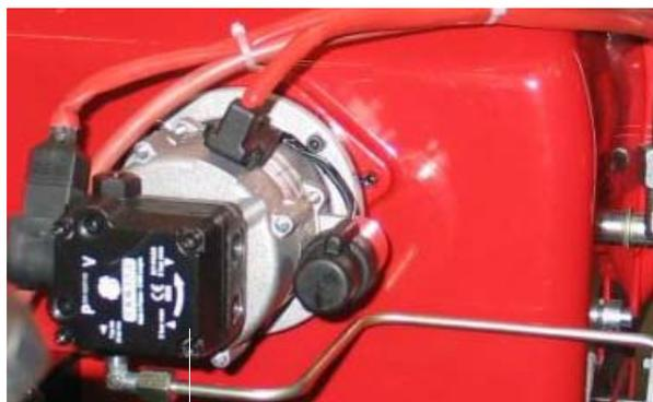
насос дизельной запальной горелки
